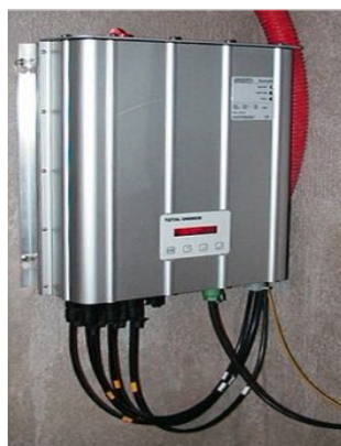
Figura 7.26 – Grid tie – equipamento que transfere a energia gerada na residência para a rede da concessionária de energia elétrica
