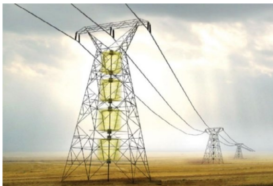
Figura 6.24 – Torre de transmissão trifásica
