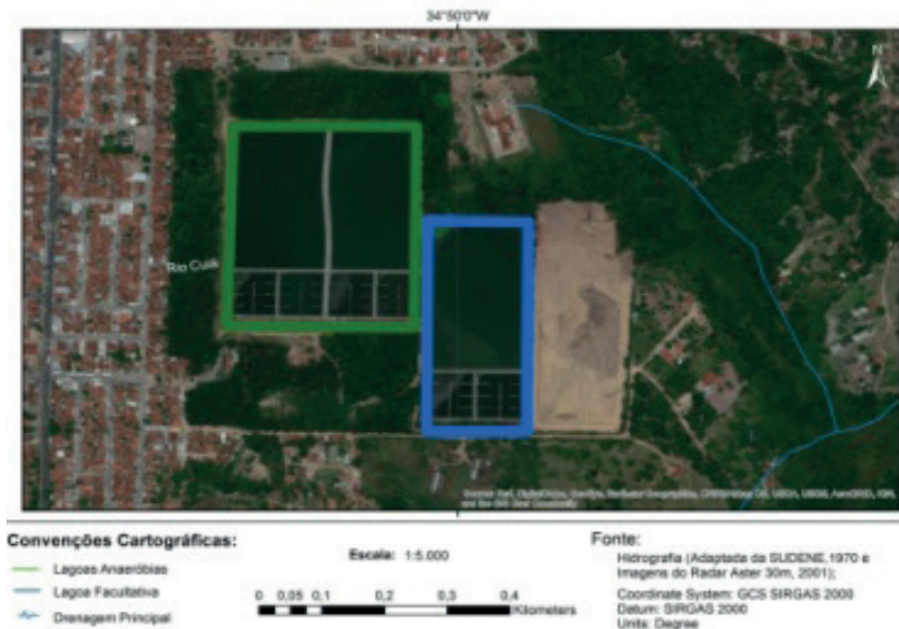
Figura 3 - ETE Mangabeira da CAGEPA
