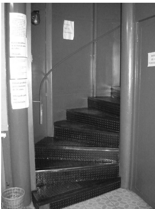
Foto 14 – A. Vinholes – Escada de acesso ao mezanino
