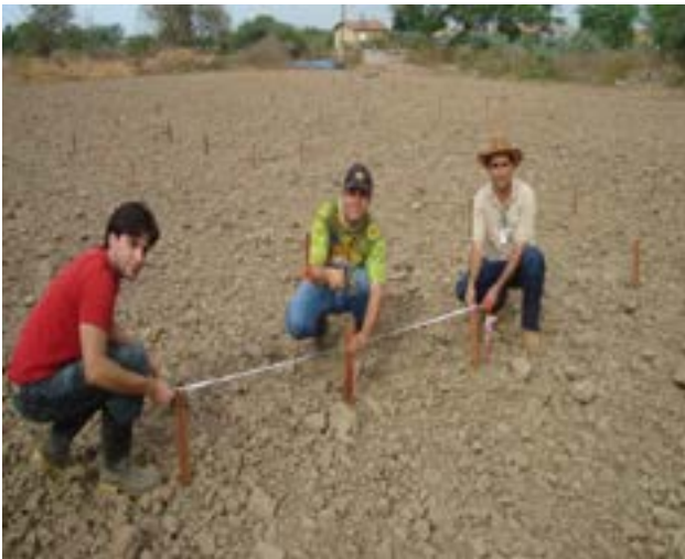
Figura 3 - Demarcação e piqueteamento da área.
