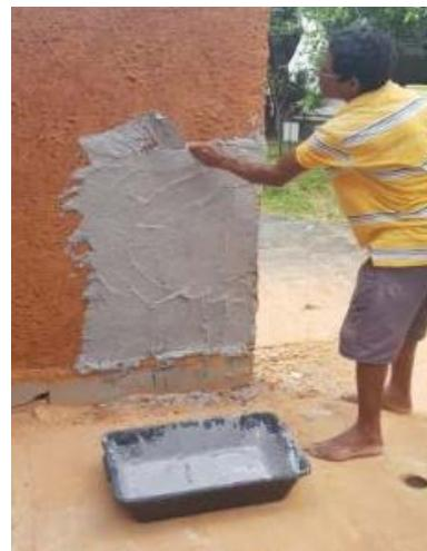
Figura 14, 15 e 16 – Preenchimento do solo pequenos orifícios no barro e reboco. Fonte: autores, 2019
