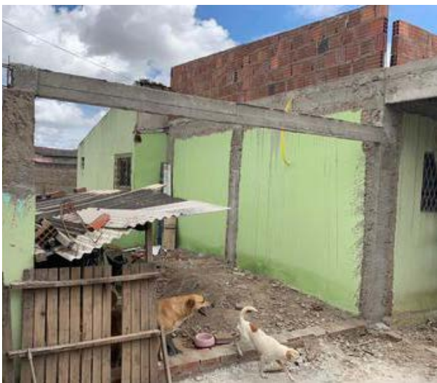
Figura 56 – Gerenciamento de obra
