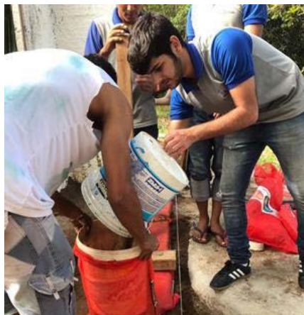
Figuras 34 e 35 – Execução da parede com hiperadobe
