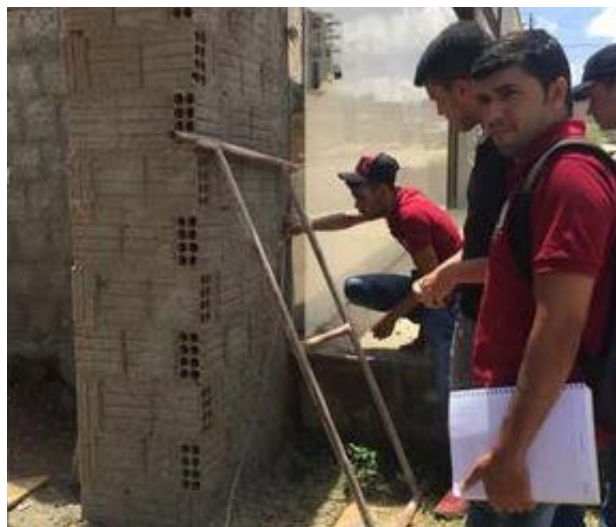
Figuras 53 – Acompanhamento de obra
