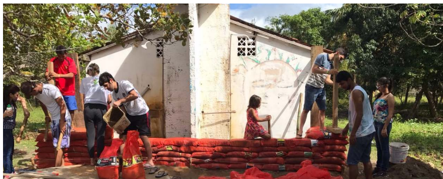
Figura 36 – Execução da parede com hiperadobe
