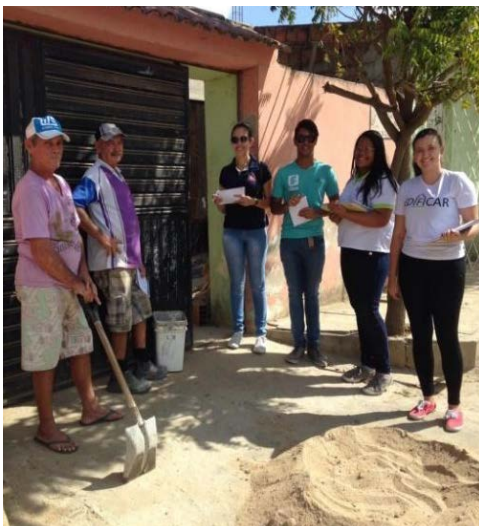
Figuras 54 – Acompanhamento de obra
