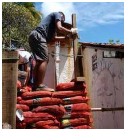
Figuras 34 e 35 – Execução da parede com hiperadobe
