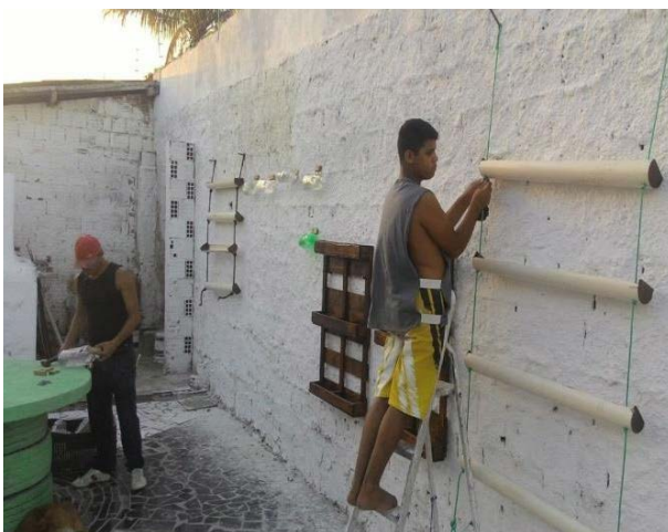
Figura 9 – Instalação de suporte para uma horta vertical
