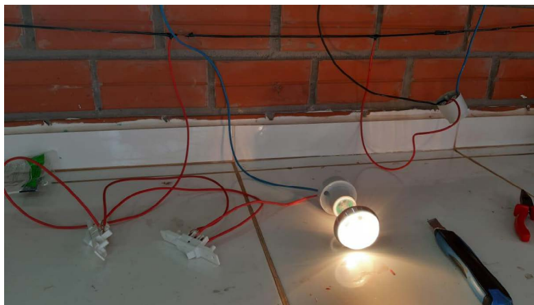
Figura 4 – instalação de uma chave hotel para acendimento de uma lâmpada.
