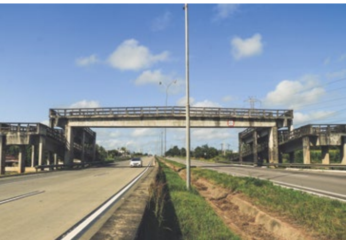
PASSARELA NA BR-101. FOTO: LEANDRO PELLIZZONI
