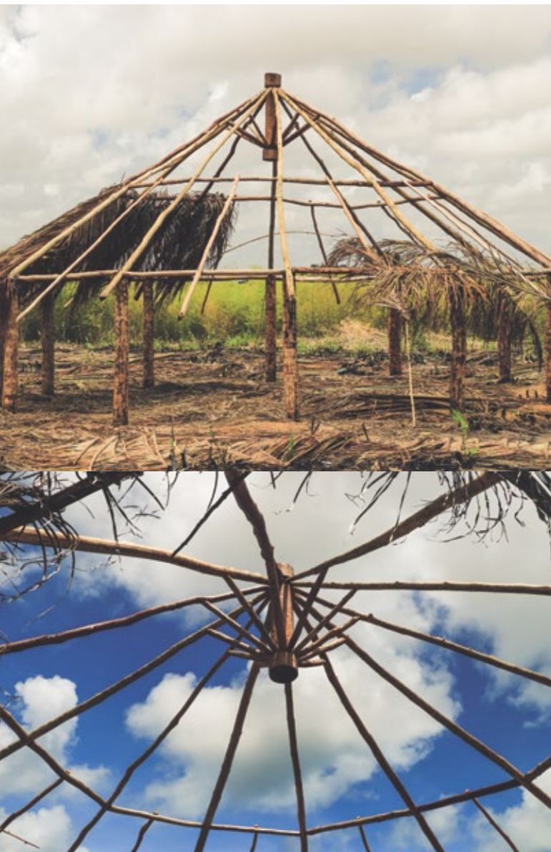
OCA CENTRAL EM CONSTRUÇÃO, ALDEIA NOVA CONQUISTA. FOTO: LEANDRO PELLIZZONI.
