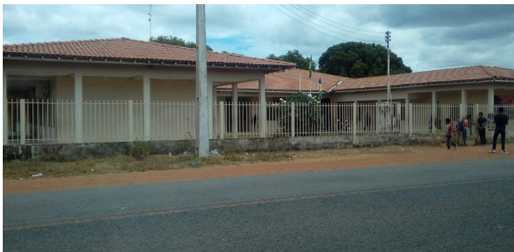
Figura 6 – Fachada da Escola Estadual Indígena Santa Luzia
