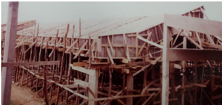
Figura 108 – Obras da construção do Campus Cajazeiras.
