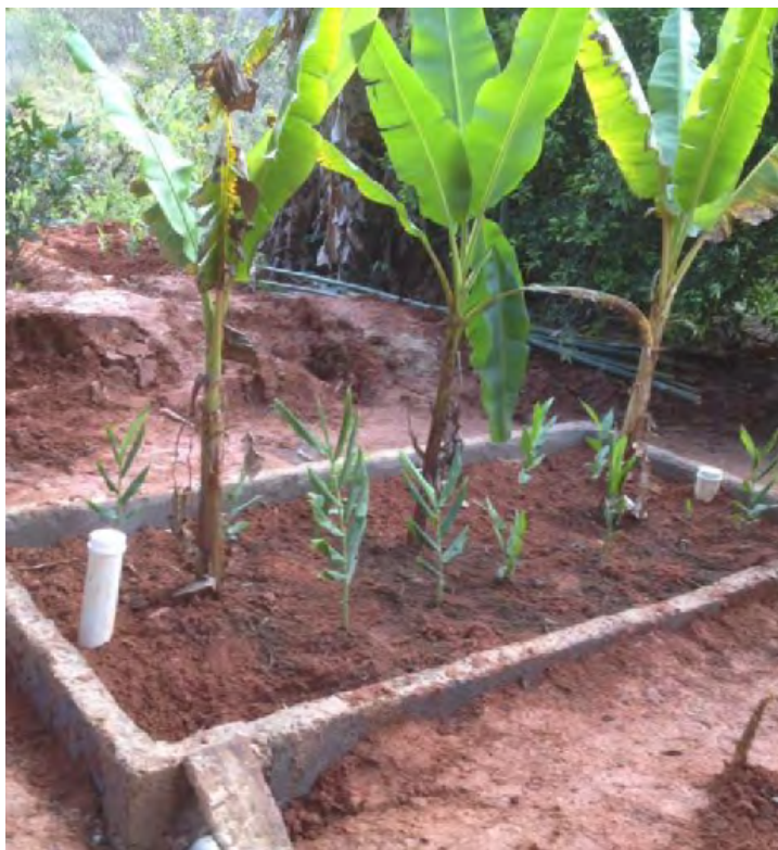
Tanque de Evapotranspiração (TEvap) ou fossa ecológica Fonte: Divulgação
