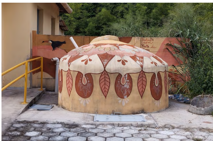
Cisterna para a captação de chuva, com pintura de tintas naturais
