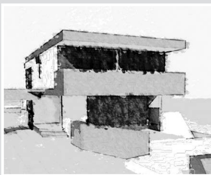
Figura 19 Casa de I. A. da S. Fonte: Adaptada do ARCEN/PMJP
