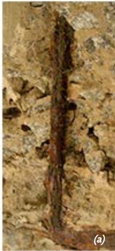
Figura 4 – Aparência superficial da corrosão generalizada desencadeada pela carbonatação do concreto (a) e da corrosão puntiforme desencadeada pela ação dos íons cloreto (b)
