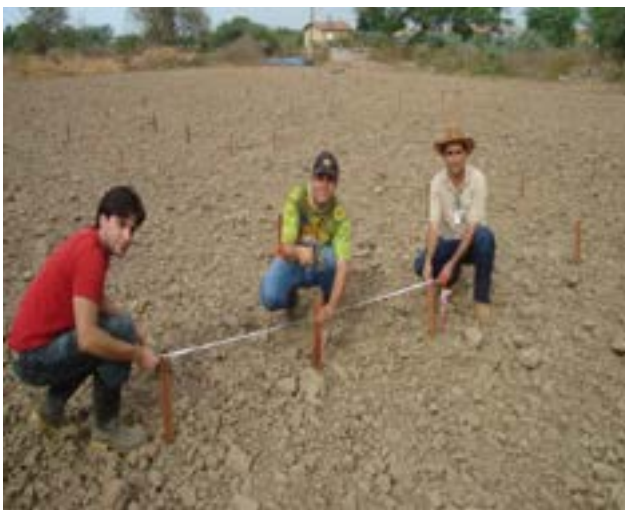
Figura 3 - Demarcação e piqueteamento da área.
