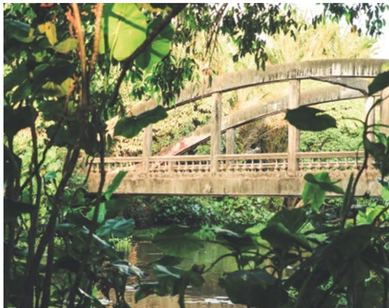
PONTE DOS ARCOS. FOTO: LEANDRO PELLIZZONI.
