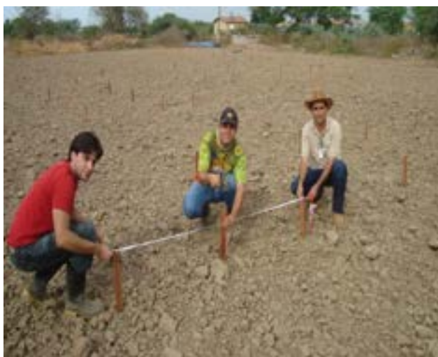
Figura 3 - Demarcação e piqueteamento da área.
