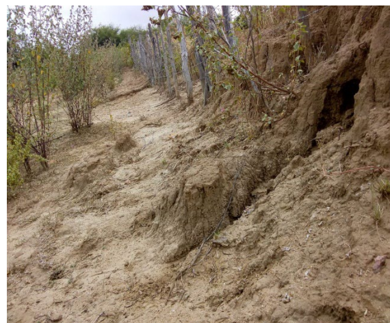
Figura 2 - Processo de erosão do solo no percurso do Rio Benevides
