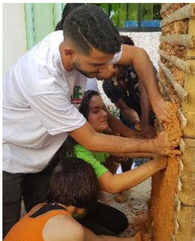
Figura 14, 15 e 16 – Preenchimento do solo pequenos orifícios no barro e reboco. Fonte: autores, 2019
