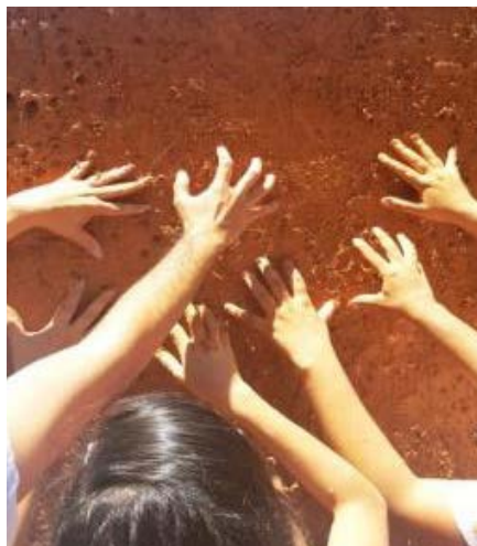
Figura 14, 15 e 16 – Preenchimento do solo pequenos orifícios no barro e reboco. Fonte: autores, 2019
