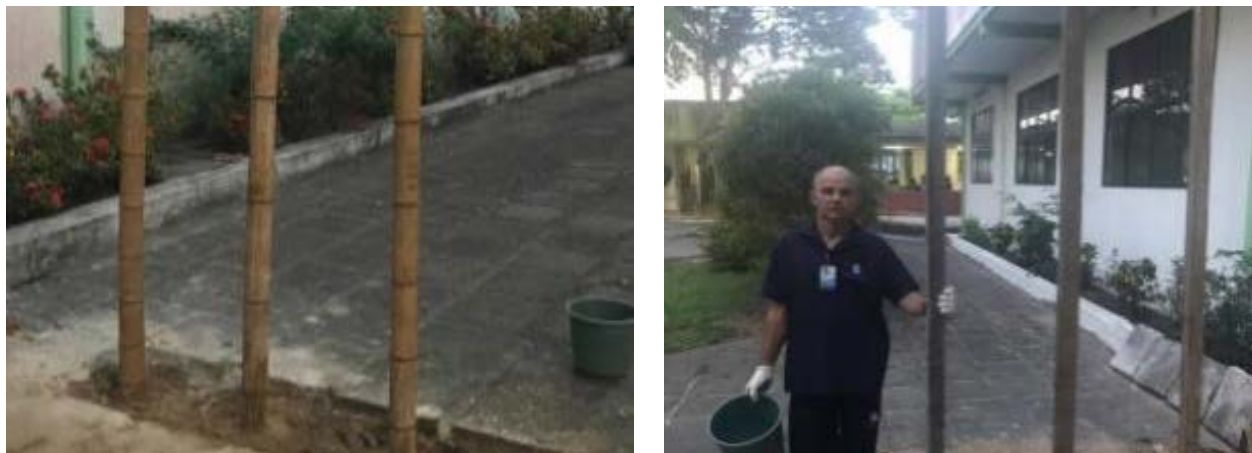
Figura 8 e 9 – Processo estrutural e calhas de concreto. Fonte: autores, 2019
