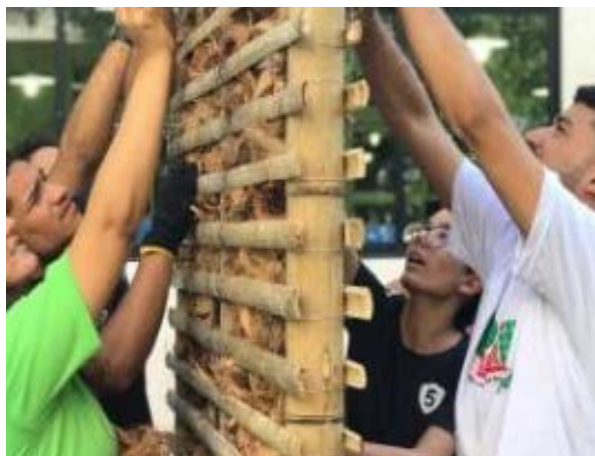
Figura 10 – Fixação das ripas de bambu e Figura 11– Inserção de fibras de coco. Fonte: autores, 2019
