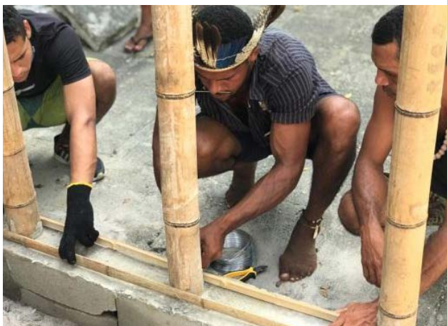
Figura 10 – Fixação das ripas de bambu e Figura 11– Inserção de fibras de coco. Fonte: autores, 2019
