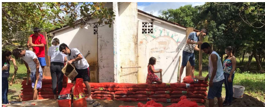
Figura 36 – Execução da parede com hiperadobe
