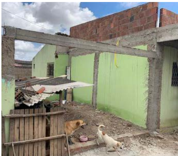
Figura 56 – Gerenciamento de obra
