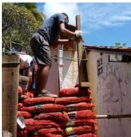
Figuras 34 e 35 – Execução da parede com hiperadobe
