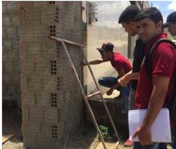
Figuras 53 – Acompanhamento de obra
