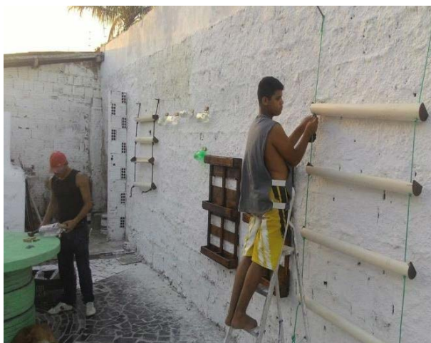
Figura 9 – Instalação de suporte para uma horta vertical
