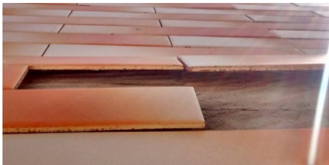
Figura 3: Placas cerâmicas parcialmente descoladas
