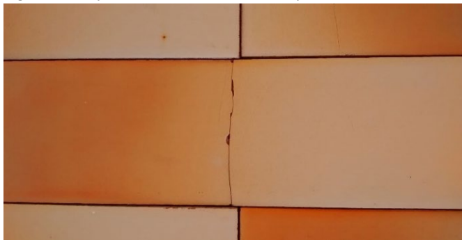
Figura 4: Ruptura identificada em uma placa cerâmica
