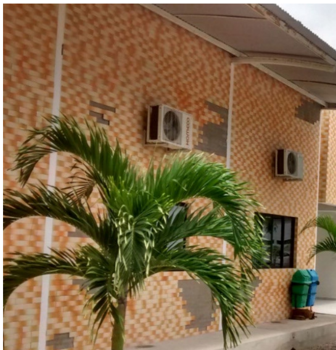
Figura 2: Fachada principal com descolamento do revestimento
