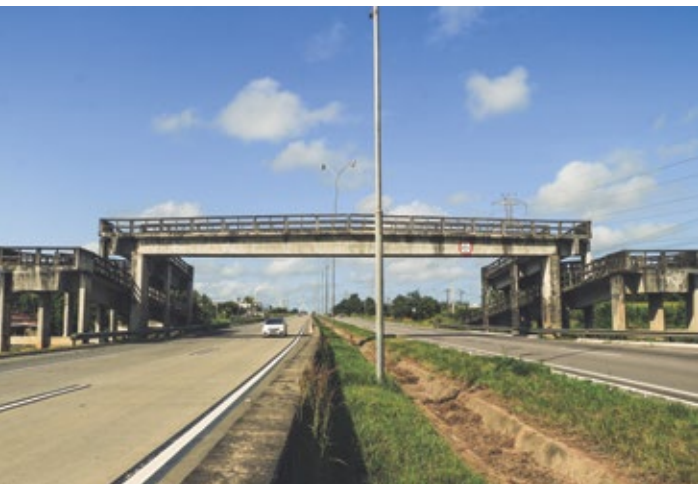
PASSARELA NA BR-101. FOTO: LEANDRO PELLIZZONI
