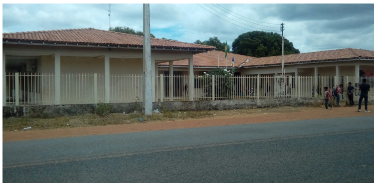
Figura 6 – Fachada da Escola Estadual Indígena Santa Luzia
