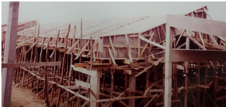
Figura 108 – Obras da construção do Campus Cajazeiras.
