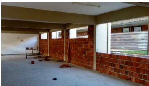
Figura 33 – Construção do Laboratório de Matemática (2017)
