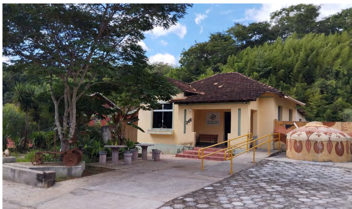
Fachada principal do Centro de Vivência em Educação e Saneamento Rural em Florestal Fonte: Divulgação
