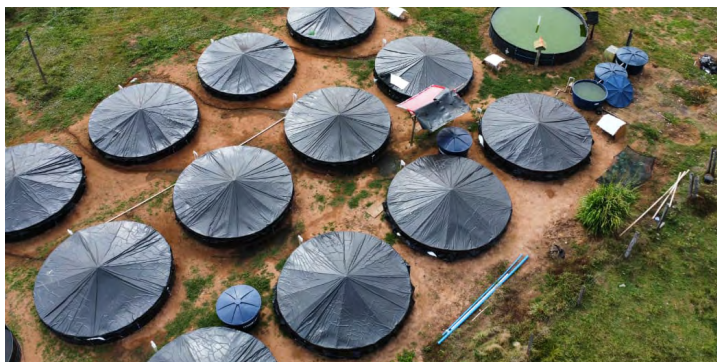
Tanques instalados em assentamento rural
