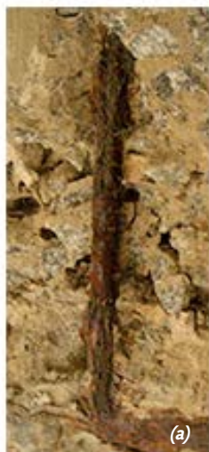
Figura 4 – Aparência superficial da corrosão generalizada desencadeada pela carbonatação do concreto (a) e da corrosão puntiforme desencadeada pela ação dos íons cloreto (b)
