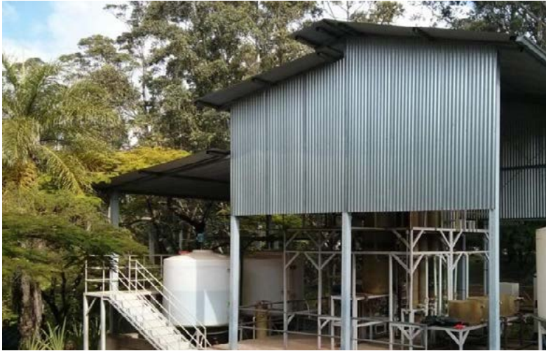
Figura 1 – Vista geral da Instalação Piloto de tratamento de água da COPASA, Belo Horizonte-MG
