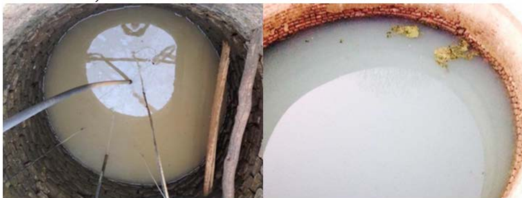
Figura 1 - Poço amazonas da comunidade Panasco e Raimundo
